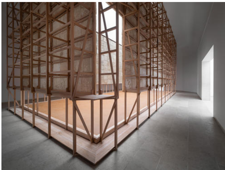
Squelette de bois de hêtre vêtu de panneaux de mycélium, alignés au puits de lumière existant, sol en pisé. Les entrées se déroulent © Ugo Carmeni
