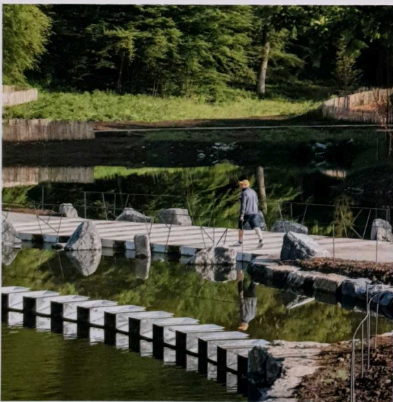
Das «Klavierkasten»-Wehr reguliert selbstständig den Wasserabfluss. Dicht daneben quert die bestehende Strasse auf einer flachen Brücke das Wasser.
