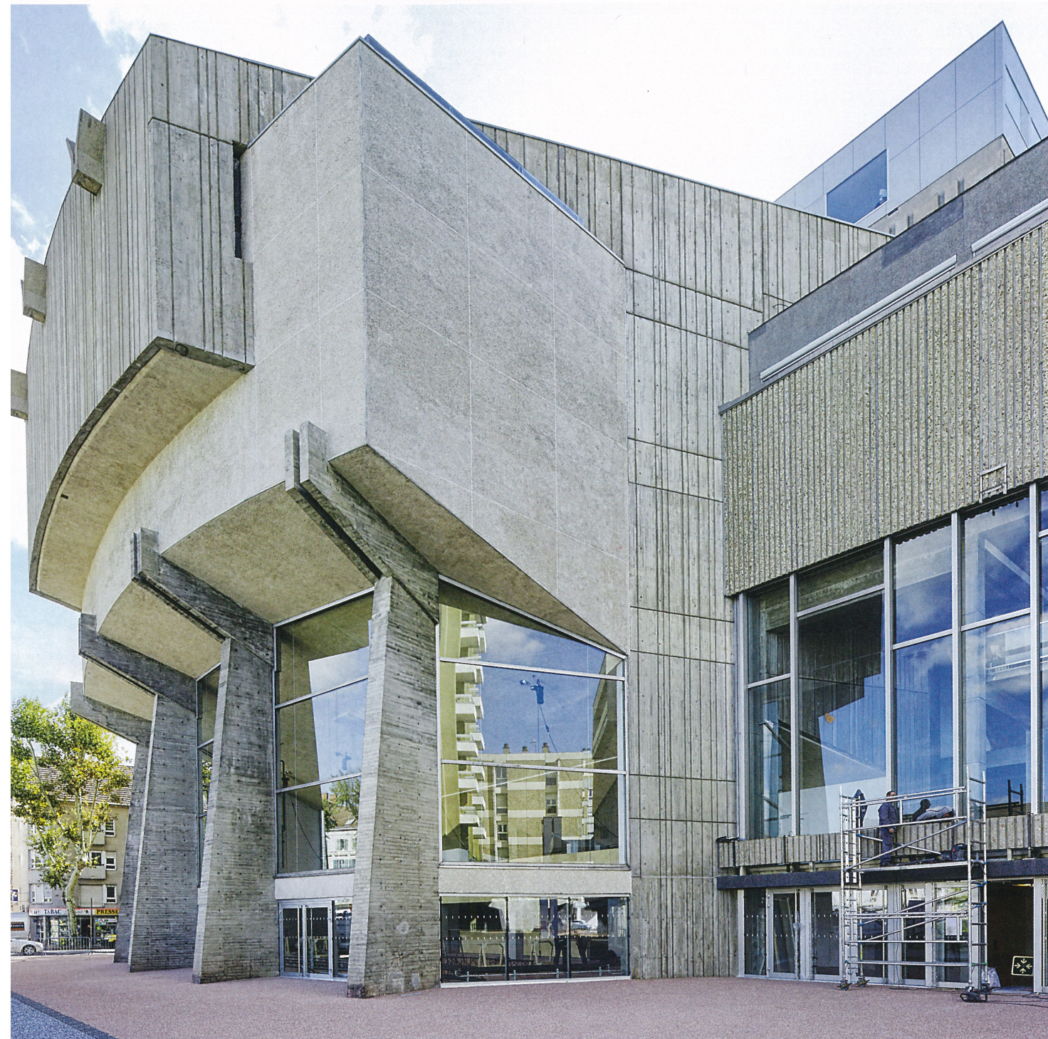
SUS. Sous la coque des gradins de la grande salle, la rotonde est de plain-pied avec le parvis. L'alle haute a été démontée et la brasserie qu'elle abrite se prolonge sur l'extérieur.
