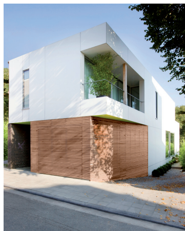
a. Rue Constantin Lepaige, 4000 Liège dsner. Nicolas Duvivier architectes © img. L. Brandajs mo / bo. Privé/Private.
