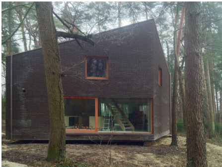
a. Allée du Vicinal, 1390 Biez stab. Luc Delvaux peb. C02 Challenge mo / bo. Privé/Private.
