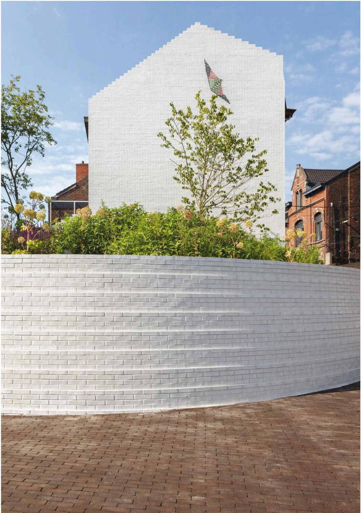
Le fruit du mur de soutènement est opéré par de légers retraits toutes les quatre rangées, formant une paroi épaisse de 93 centimètres. The angle of the retaining wall is formed by slight recesses every four rows, resulting in a 93-centimetre-thick wall.
